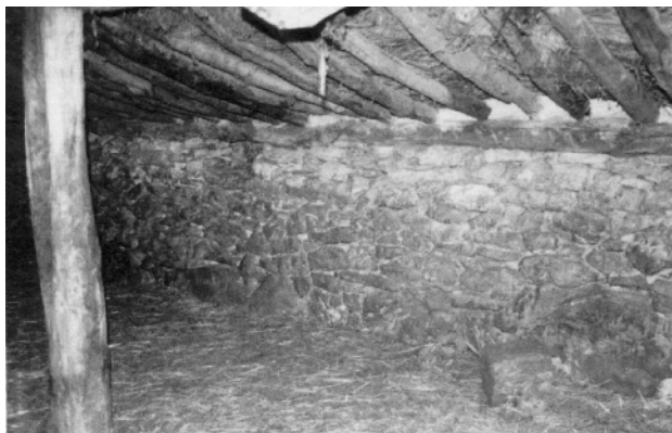
Paridera. Interior, muro con relleno de adobe
