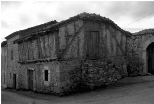
Edificio de una de las dos Tabonas. En su interior no queda nada de su anterior función.
