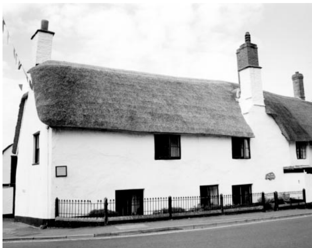
Conservación de cubiertas de paja. AVEBURY. Centro de Inglaterra.
