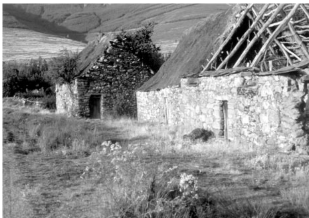
Desintegración y deterioro. TRUCHAS
