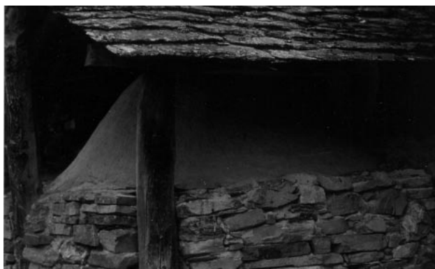
Horno con tejadillo en vivienda de una sola planta (Villar del Monte)
