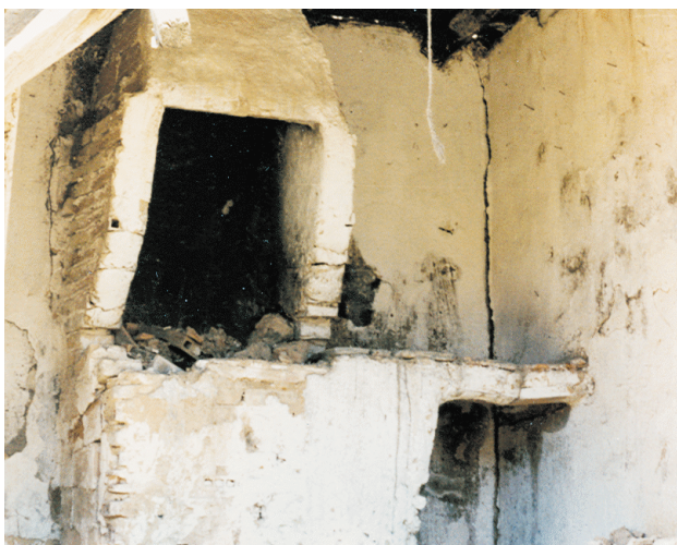
Figura 13. Cocina de faldón de una casa en ruinas de Roa, en la que el fogón es más alto que en los casos anteriores y más cómodo para cocinar. El faldón se cierra por ambos lados en forma de hornilla para concentrar mejor el calor y gastar menos combustible; sin embargo, sólo sirve para cocinar, pues apenas calienta la habitación.
