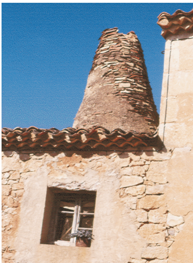
Figura 14. Exterior de una chimenea de cocina de campana del pueblo de Valdeande. Tanto en las chimeneas de cesto como en las de adobe, la parte que sobresale del tejado se recubre con barro y trozos de tejas colocadas en forma de escamas para protección frente a la lluvia. Ésta ha perdido el copete de cuatro tablas o tejas que antaño solían tener todas.
