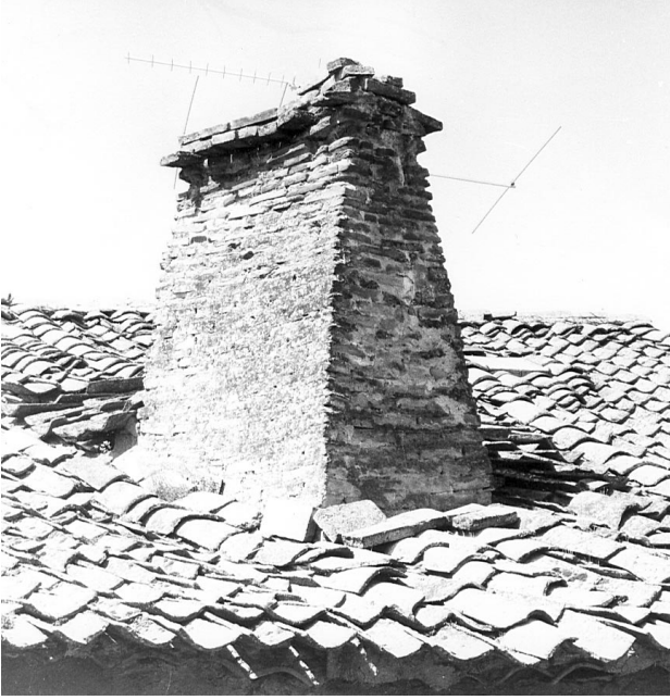
Figura 16. Exterior de una chimenea de Hoyales, hecha de ladrillo, de tipo troncopiramidal, con hueco de salida de humos perpendicular al muro. Es una modernización que sustituye el entramado revocado por el ladrillo, que en el siglo XX fue muy empleado por su resistencia a la lluvia.
