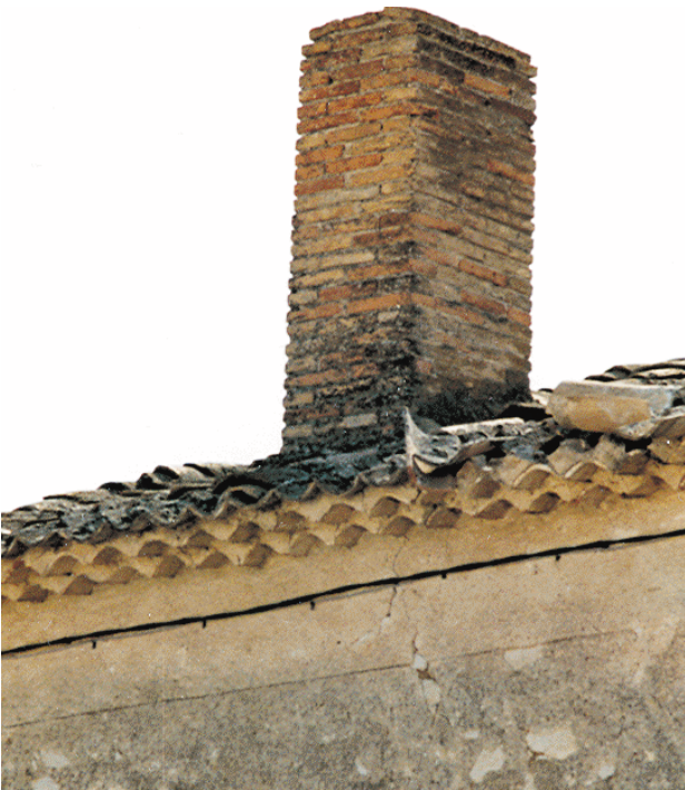
Figura 17. Chimenea de una casa de Haza, de forma prismática y hecha con ladrillo, que ha sido el tipo más utilizado para las cocinas de faldón; la parte interna tiene la misma estructura de la que está a la vista.
