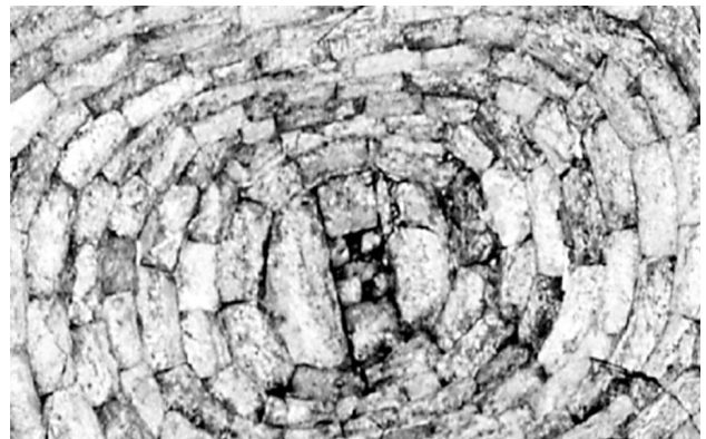
Cúpula por aproximación de biladas
