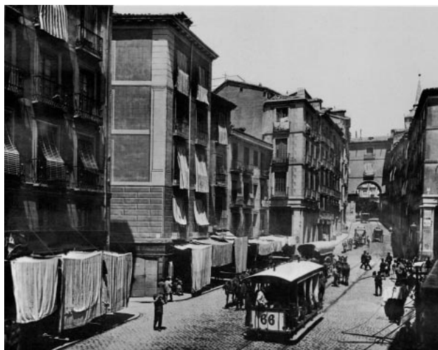
El milagro de la fotografía, nos permite apreciar hoy casi la misma calle de Toledo que contempló Jacinta camino a los barrios bajos del Rastro. Desaparecidas hoy las cortinas, que protegían el típico balcón madrileño, han quedado sobre el dintel de muchos de ellos las barras de hierro que antaño las sostuvieron (Col. del autor).
