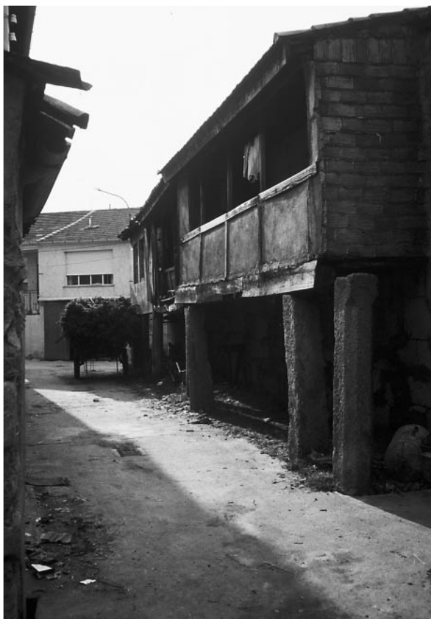
Estrume en la calle al pie de la casa. Era costumbre general. Ginzo
