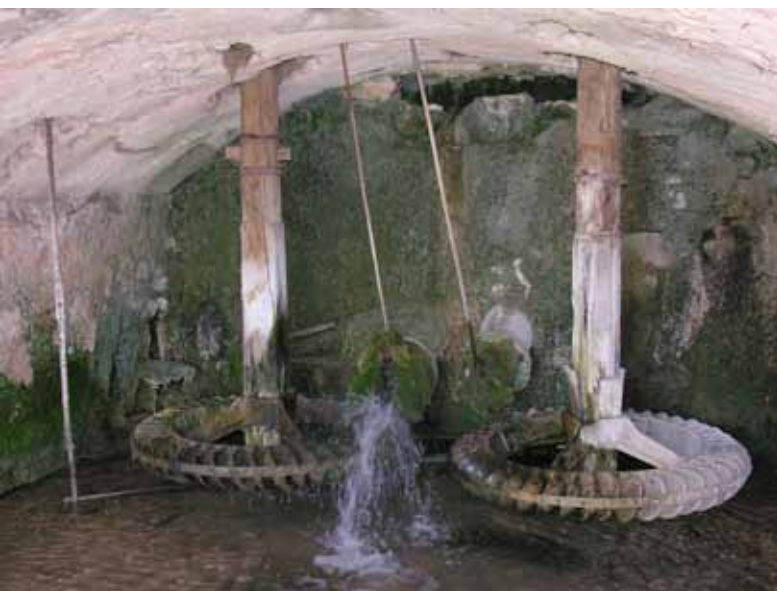
Molino de Huerta del Rey: a la izquierda, interior del cárcavo con dos rodeznos al completo; a la izquierda el caz de los molinos, recogido en la toponimia
