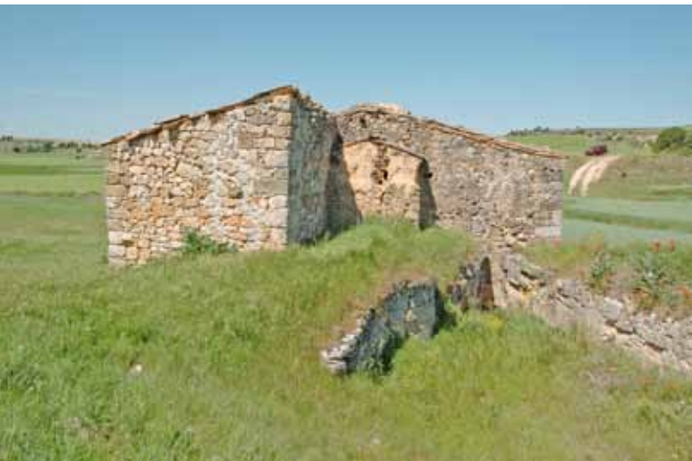
Dos ejemplos de molinos burgaleses primitivos de sencilla compostura: a la izquierda el Molino de Pineda-Trasmonte visto desde el lado de la balsa, cuyos restos se aprecian en primer término, por delante del edificio; a la derecha, el Molino de Horas en Cabañas de Esgueva, con su cárcavo adintelado sostenido mediante viga de madera
