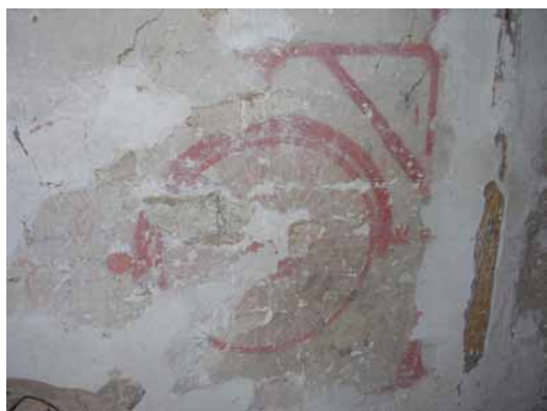
Molino de Debajo de Villovela de Esgueva (de izquierda a derecha y de arriba abajo): estado actual del edificio; interior de la sala de molienda con sus dos empiedros; dibujo en la pared con el rayado de una muela a modo de guía para la operación de picado; dibujo de otra muela con la cabria
