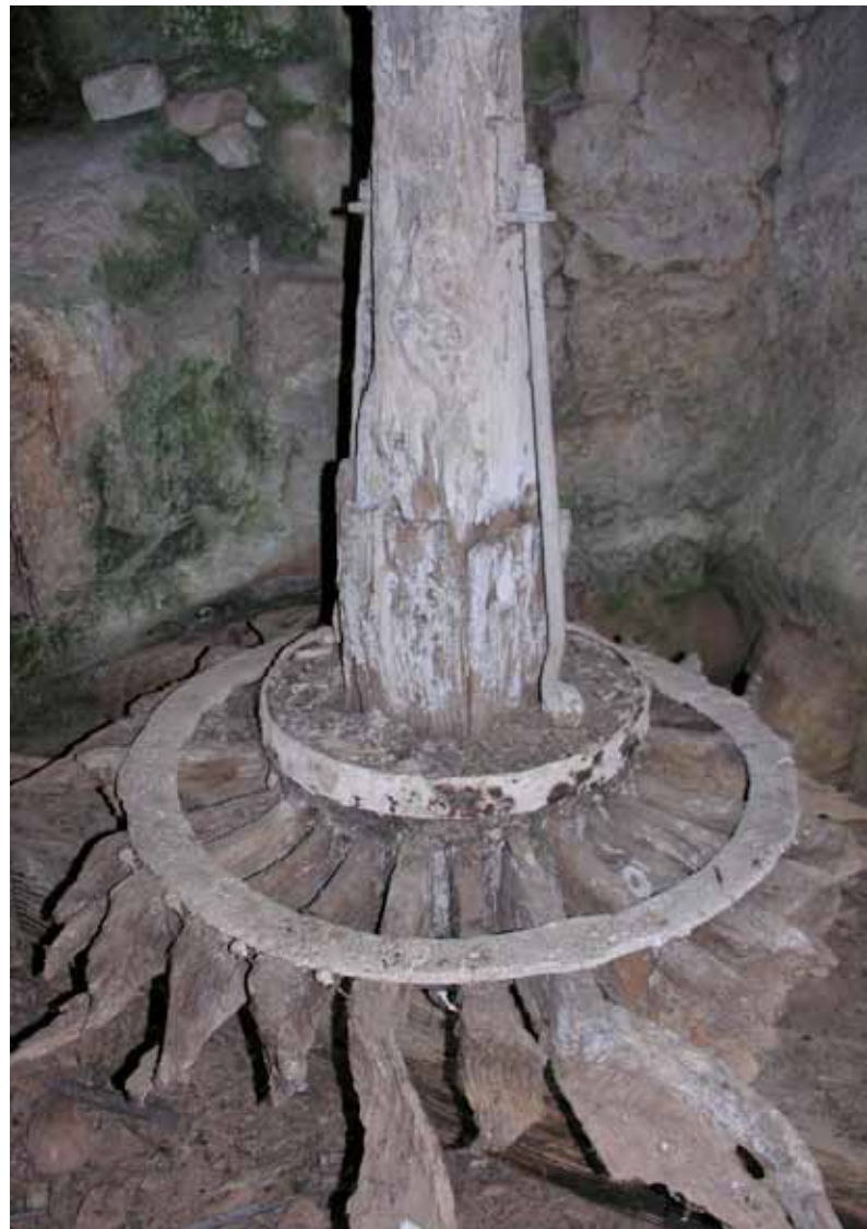
Molino del Suso, en Gumiel de Izán: a la izquierda, vista del cárcavo; a la derecha los restos del primitivo rodezno de madera
