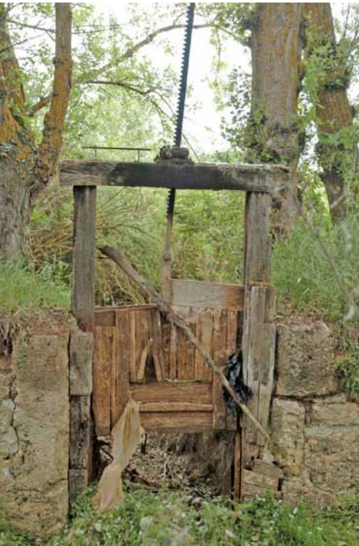
A la izquierda, compuerta de madera para regulación del aliviadero en el Molino del Pueblo, en La Aguilera; a la derecha, el socaz del Molino de la Puente, en Tubilla del Lago
