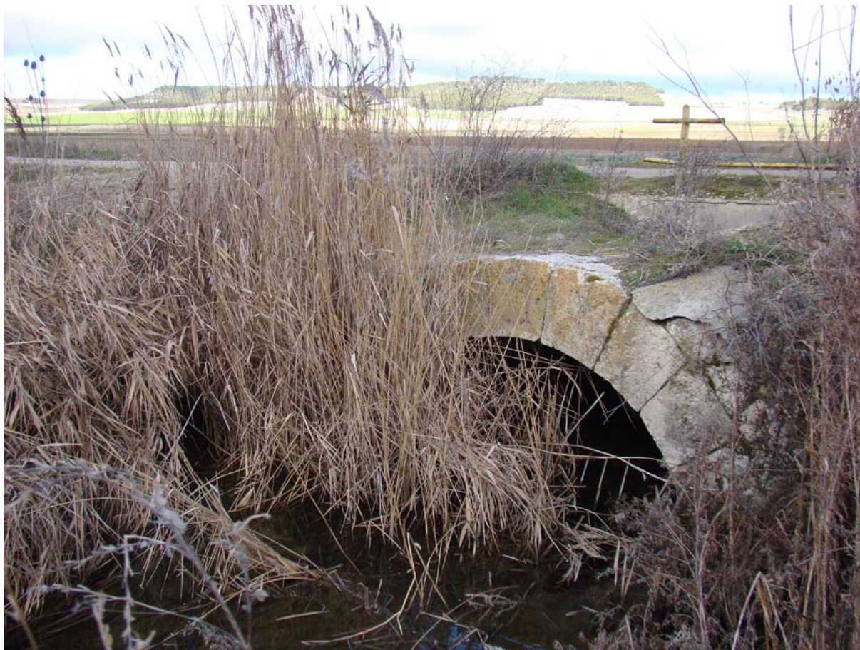
Puente sobre el arroyo Jaramiel, en Tudela de Duero, bajo la mambra
