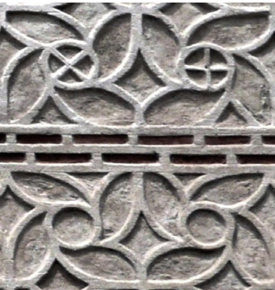
Fig. 28. Detalle del esgrafiado de la torre de Arias Dávila, de mediados del siglo xv
