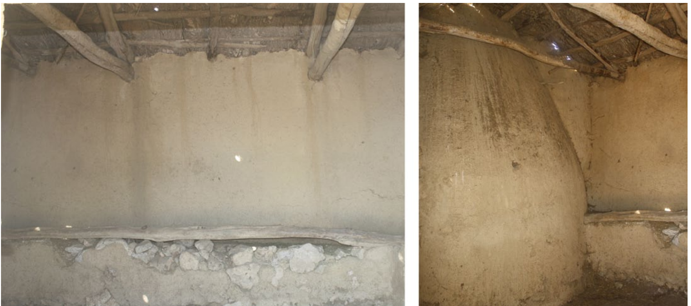
Fig. 12. Imágenes interiores de la caseta de Norberto (septiembre de 2011), donde se ve el pesebre, la cubierta y la intersección con el chozo levantado anteriormente
