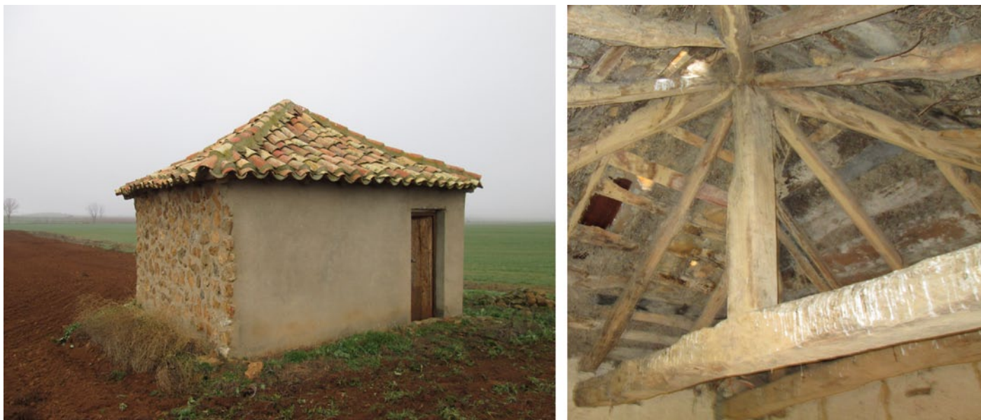
Fig. 13. Imágenes de la caseta de Francisco (diciembre de 2014). Fuente: autor
