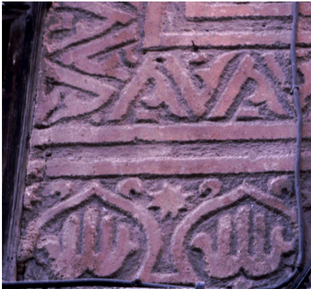
Fig. 8. Esgrafiado con friso de manos en una casa de la travesía del Conde de Toledo
