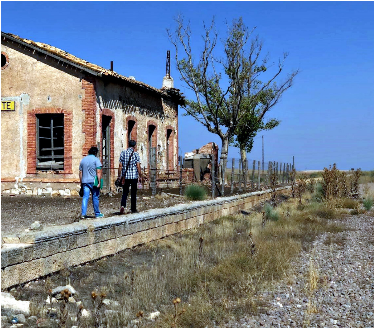
Estación de tren abandonada de Hijate perteneciente a la línea férrea Guadix-Baza-Almendricos. Foto: Antonio Francisco Martínez
