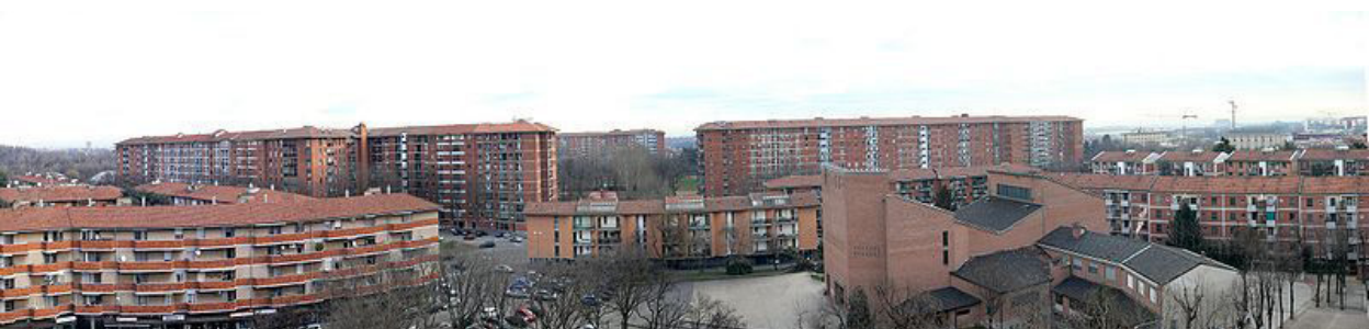
Milano Quartiere Feltre, costruito negli anni '50 del '900
