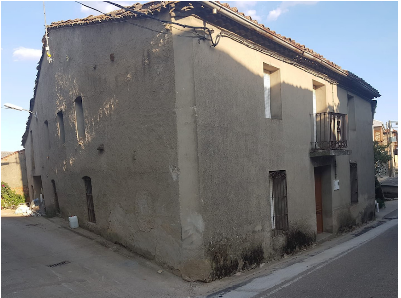
Casa del «Tío Perico», fachada original. Actualmente se ha enfoscado
